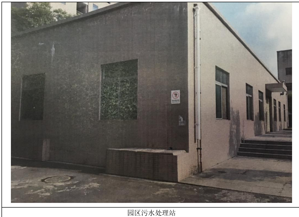
图 7 项目废水处理系统照片
