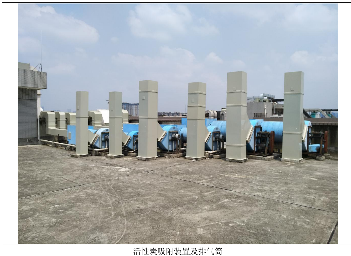
图 9 项目废气处理系统照片
